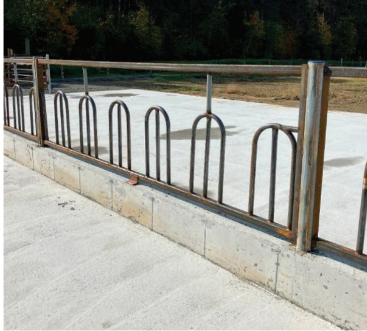
Muret de béton surmonté de barrières arrondies • Crédit : Véronique Gagnon, ing., MAPAQ
