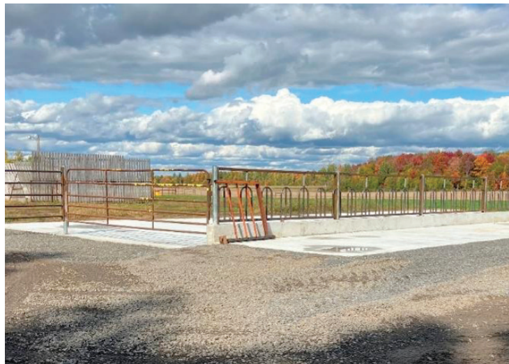
Mangeoire longitudinale en béton • Crédit : Véronique Gagnon, ing., MAPAQ
