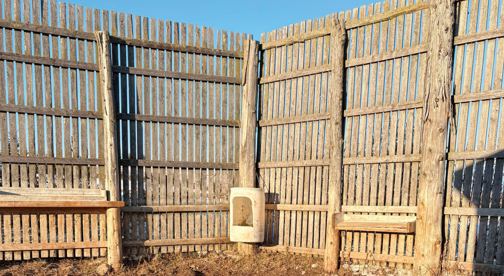
Brise-vent de 4 mètres (12 pieds) avec poteaux de bois aux 3 mètres (10 pieds) • Crédit : Catherine Larivée Bazinet, agr., Les Producteurs de bovins du Québec
