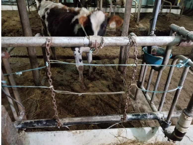
Figure 15: Installation réparée avec des cordes
